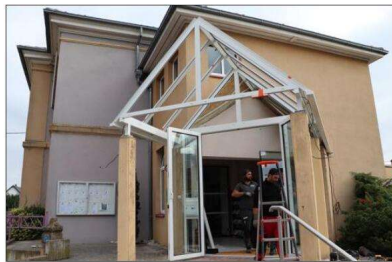
Un nouveau sas d'entrée pour la mairie afin d'améliorer l'isolation de l'édifice. Photo L'Alsace/Christian WERTHE
