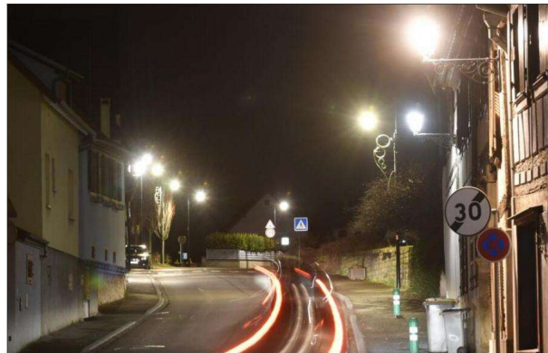
À l'exception de trois rues qui feront l'objet d'une réflexion ultérieure, Gertwiller va voir tout son éclairage modernisé à partir de 2022, pour effectuer des économies d'énergie. Archives DNA
