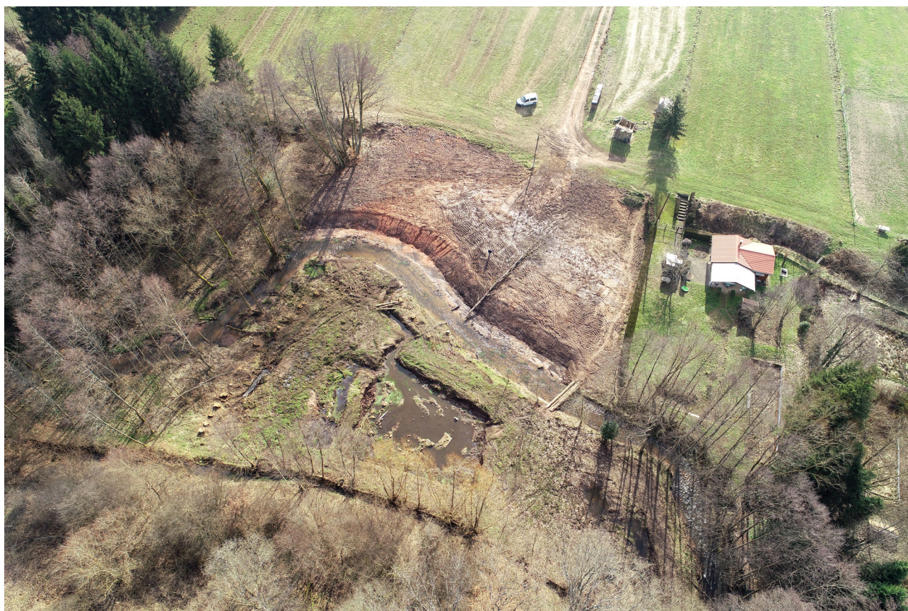
Vue aérienne du site (par drone) après les travaux de la première phase © PNRVN
