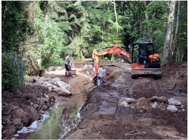
Aménagement du nouveau lit de contournement © CEN Alsace
