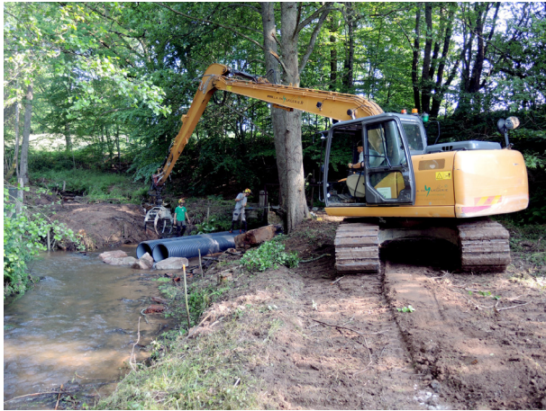
Préparation de l'accès pour la création du nouveau lit de contournement de l'ouvrage seuil © CEN Alsace
