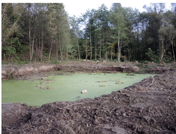
Anciennes berges bétonnées de l'étang démantelées © CEN Alsace
