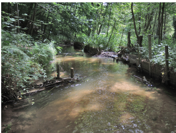
Stabilisation du lit de la rivière avec divers matériaux de récupération © CEN Alsace
