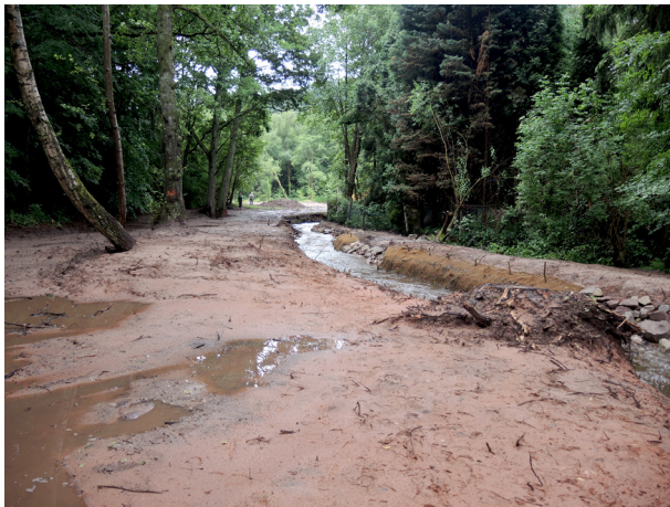
Nouveau lit de contournement de la Moder après mise en eau © CEN Alsace
