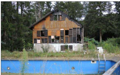
Avant les travaux : des constructions et dépendances en ruine, des débris de toutes sortes et des plantations diverses (résineux, plantes exotiques) étaient dans le lit majeur de la rivière. DR
