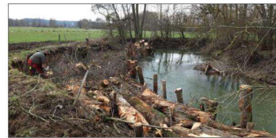
Parmi les travaux d'entretien réalisés cet hiver, le traitement des embâcles sous forme de peigne : une technique végétale vivante qui permet la reconstitution naturelle des berges et des ripisylves ainsi que le maintien du biotope des embâcles. Photo Épage Largue
