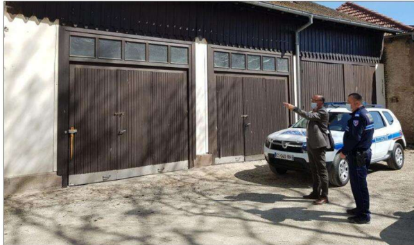
Les garages situés dans les jardins de l'ancienne sous-préfecture pourraient accueillir d'ici peu les nouveaux locaux de la police municipale du Pays d'Erstein. Photo DNA
