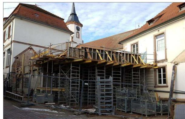
La structure en bois qui fera la jonction entre les deux bâtiments sera bientôt montée. Photo DNA
