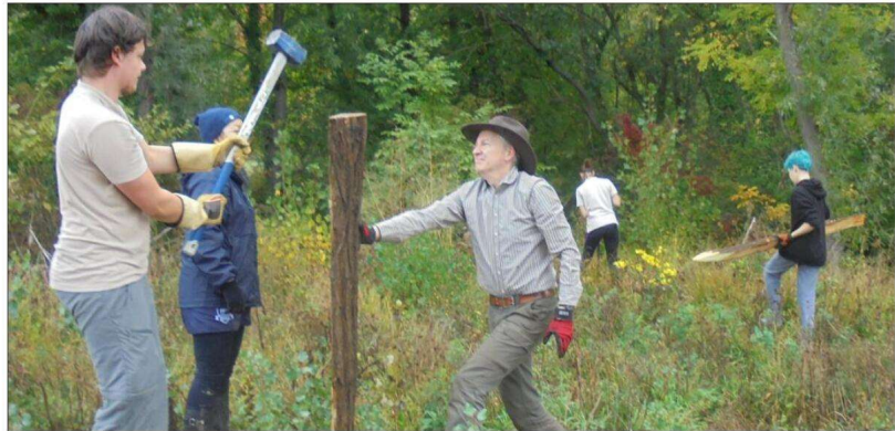
La pose d'un grillage de protection près de la mare « Fée Libellule » fait partie des chantiers nature du Conservatoire des sites alsaciens. Photo DNA
