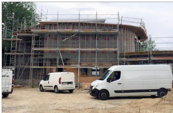
Interrompus pendant sept semaines, les travaux sont en cours au groupe scolaire, pour une livraison espérée à la Toussaint. PHOTO DNA
