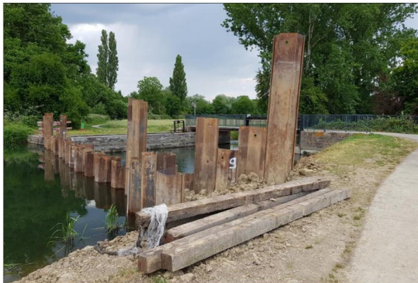
La fin des travaux est prévue pour septembre. Photo DNA
