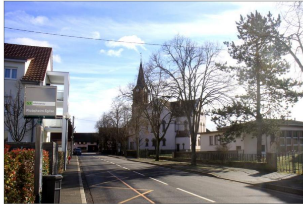
L'éclairage public, rue de l'Église, sera mis aux normes. Ailleurs dans la commune, les « têtes de lampes » de 87 luminaires seront remplacées par des LED. Photo DNA/G.I.M.
