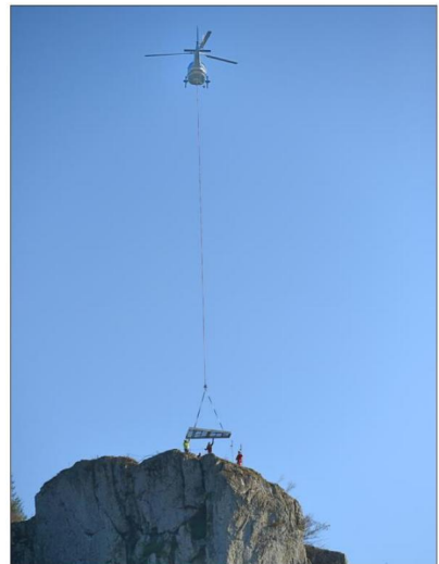
La terrasse a été acheminée par un hélicoptère. Photo DNA
