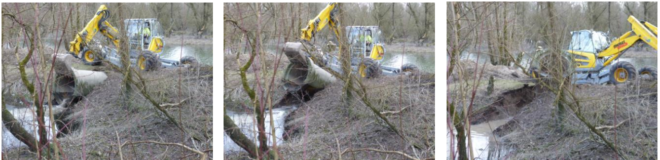
Extraction d'une buse au niveau du Nothelfer par soulèvement
