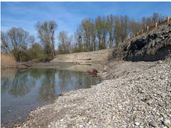
Abrupt lié au décaissement de la butte au nord-est, 20/03/2011 © Luc Dietrich
