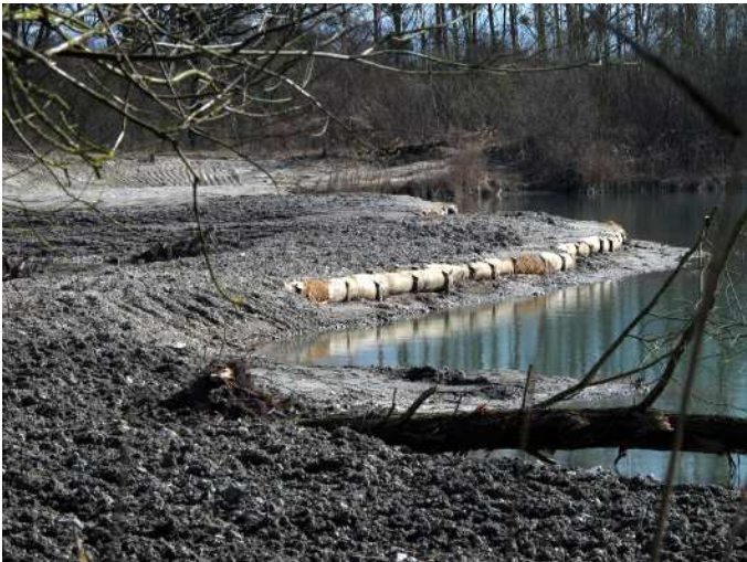
Protection contre le batillage au nord-est, 20/03/2011 © Luc Dietrich
