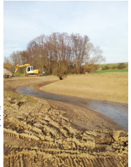
Reméandrage d'un cours d'eau dans le cadre des MCE de la LGV Est. Photo : M. Durousseau - CSA
