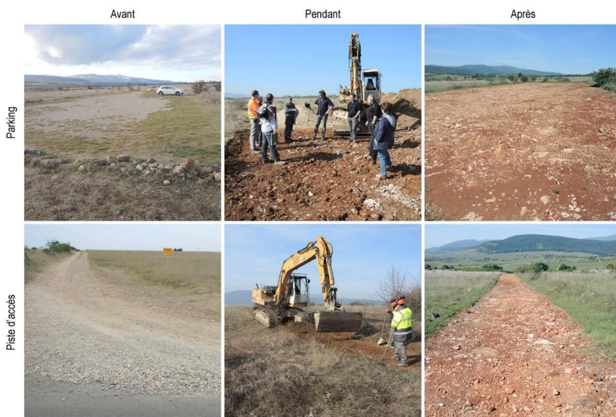
Restauration de pelouses sèches pionnières sur l'emprise de l'ancien parking du terrain d'aéromodélisme et de la piste d'accès dans la RNR de Rouffach . DIETRICH L. (CSA)
