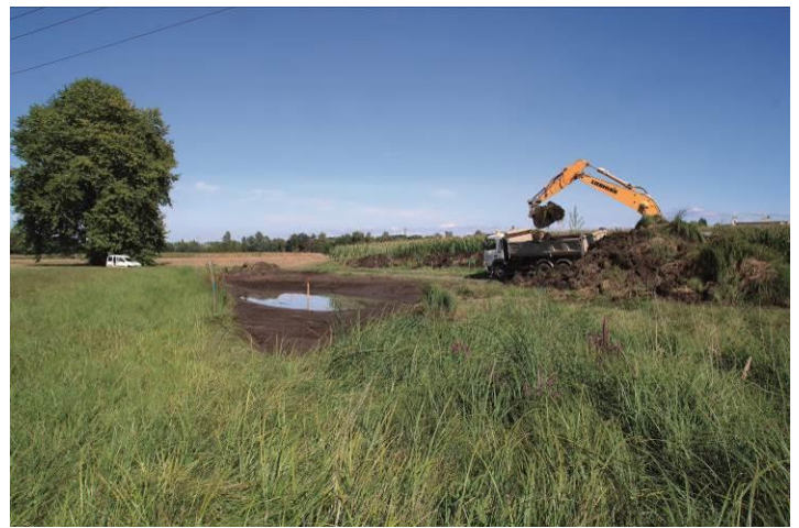
Chantier à Illkirch-Graffenstaden "Hertenmatten" 22 août 2017 - Photo P. GOERTZ
