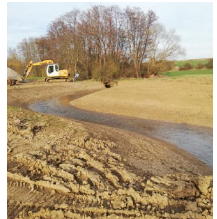
Reméandrage d'un cours d'eau dans le cadre des MCE de la LGV Est.
